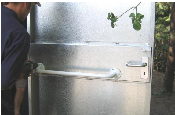
Grab rail on door
